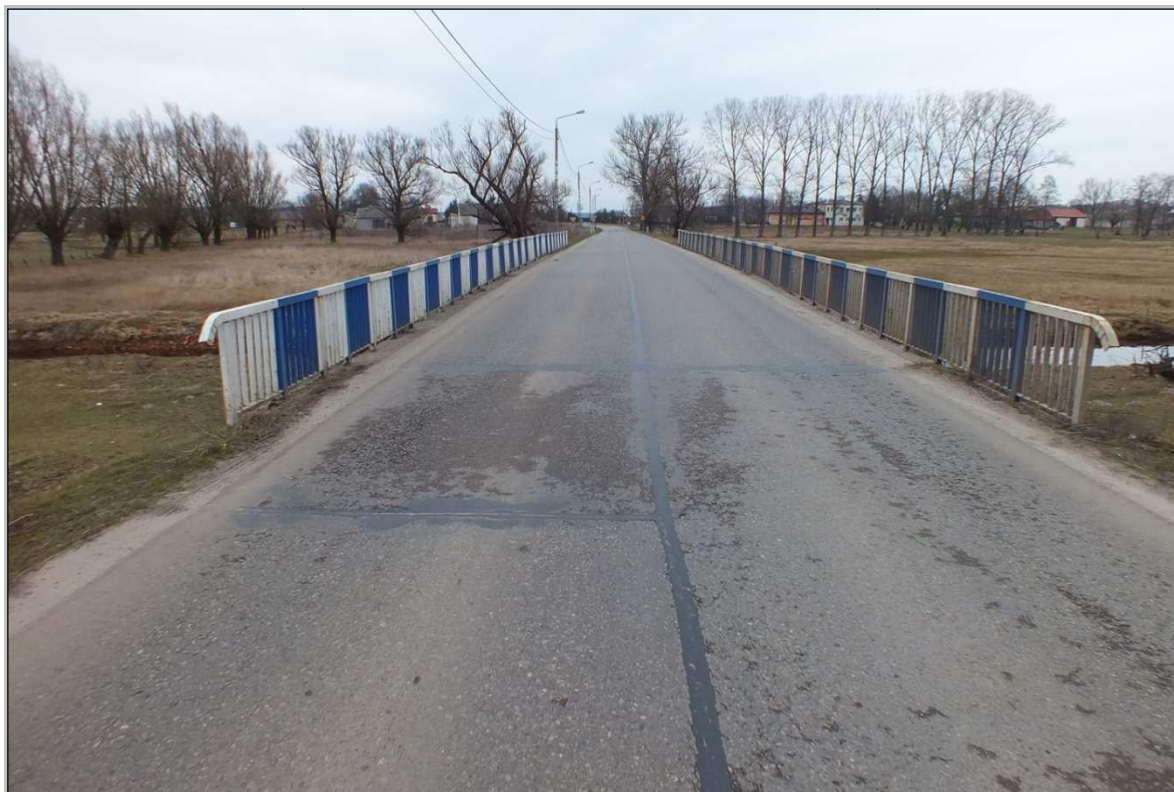
Rys. 2.3 Widok na obiekt od strony Radzymina
