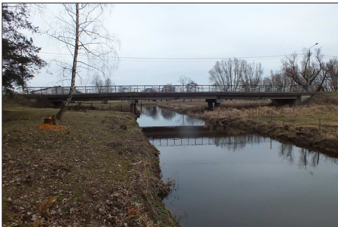
Rys. 2.2 Widok na obiekt od strony wody górnej
